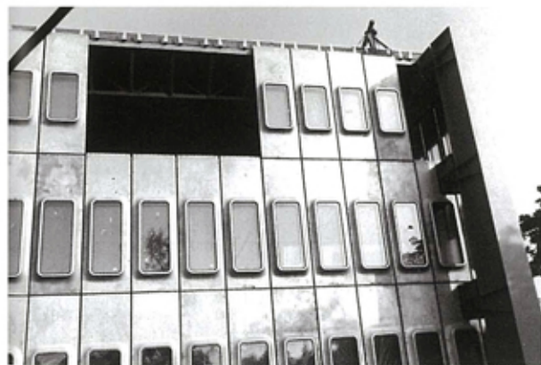
Fabrication et montage des panneaux sur l'ossature, 1969.
