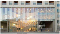
À Neuilly, médiathèque Jean d'Ormesson par Atelier du Pont
